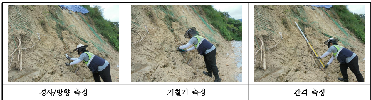
【사진 14.3.2】 불연속면 측정 현황
